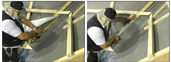
приклеивается двухсторонняя самоклеющаяся лента пояса подкровельной пленки к ендове. Контрбрус к ендове крепится саморезом, под который наклеивается уплотняющая клейкая лента во избежание течи в ендове. Обрешетка, размещенная в ендове необходимо подрезать на глубину 15 мм, чтобы закрепить желоб
