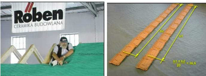
черепиц. Укладывать необходимо верхней стороной вниз вертикально на смещение и размещение так, чтобы передние складки сцеплялись. Размеры на смещение и размещение между первой и последней черепицей суммируются и делится на 20. Средняя величина реек составила 366 мм. Максимальный допуск к расстоянию погрешность около 3 мм. Поэтому допускается шаг обрешетки выполнять в диапазоне от 366 до 369 мм. Затем на
