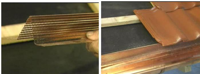
подкровельной гидроизоляционной пленки. После плотной укладки подкровельной мембраны монтируется гребень свеса из перфорированного металлического профиля. Перфорация уголка должна иметь 62 %, что при высоте в 65 мм дает 400 см впуска воздуха на погонный метр.
