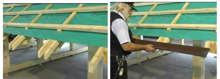
Данный вариант устройства карнизного свеса используется при небольшом угле уклона кровли. В стропилах делаются прорезы в которые монтируется карнизная планка. Затем набивается контрбрус для свеса и монтируется гребень свеса высотой 60 мм.
